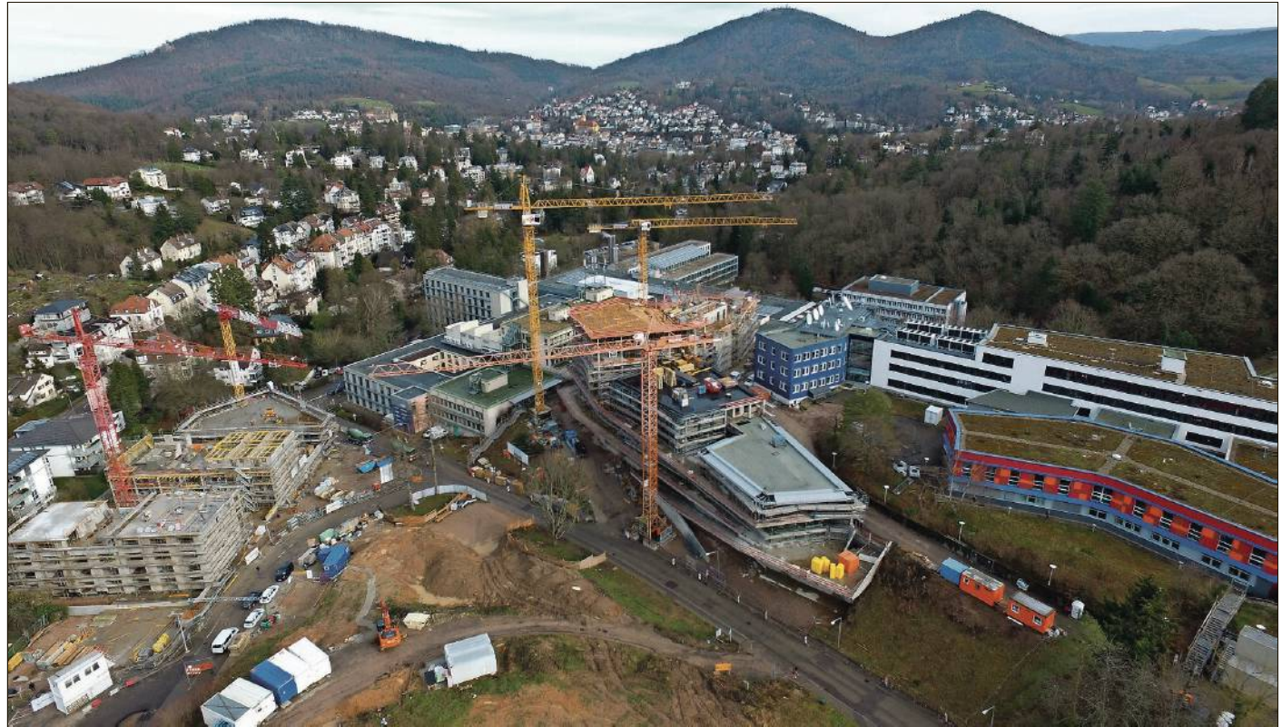
Großbaustelle auf der Funkhöhe: Das neue Medienzentrum (Mitte) des SWR nimmt sichtbar Gestalt an.
