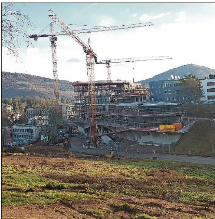
Die Kräne am Medienzentrum sollen bald schon abgebaut werden.
